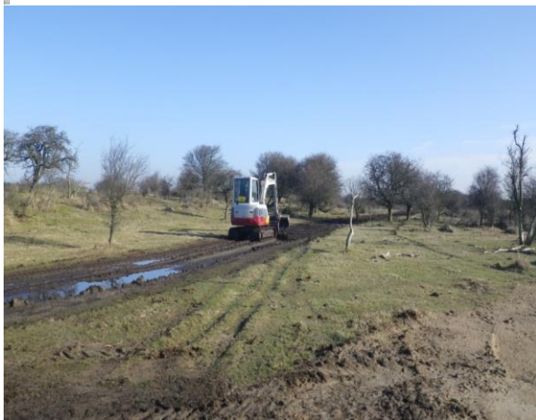
Herstellen van kapot gereden pad met kraan
