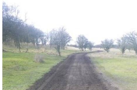
Foto pad na herstel werkzaamheden
