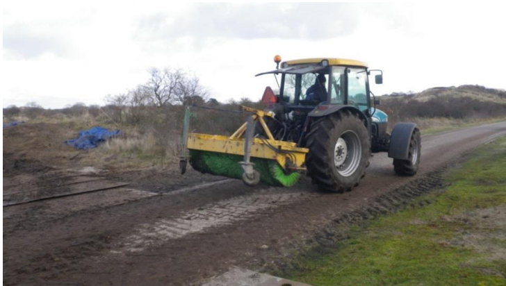
Vegen van de klinkerwegen tijdens en na uitvoering werkzaamheden
