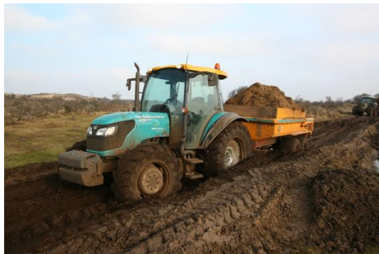
Foto pad tijdens werkzaamheden
