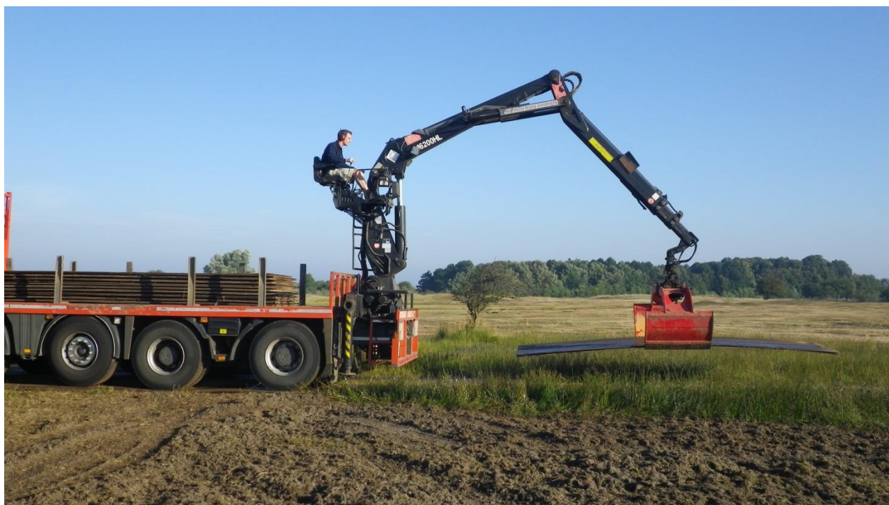
Aanbrengen van rijplaten op het Groot Zwarte veld
